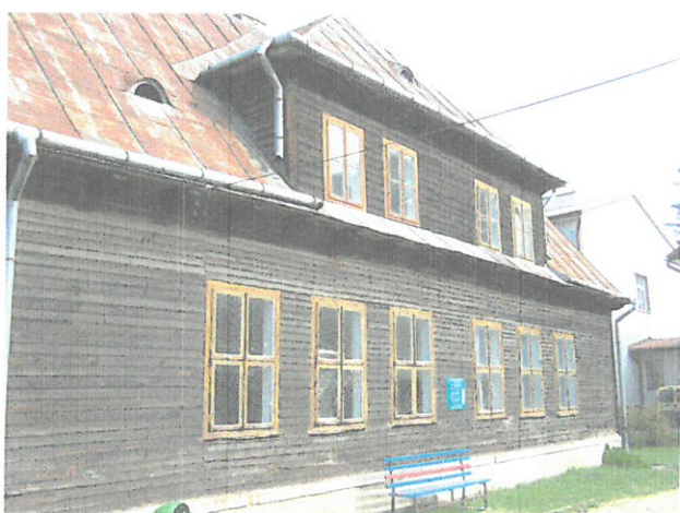
Widok budynku od strony Pd
